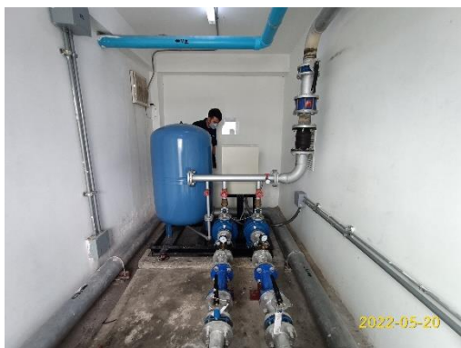
ปั้มน้ำ/ปั้มเสริมแรงดันอาคาร A
