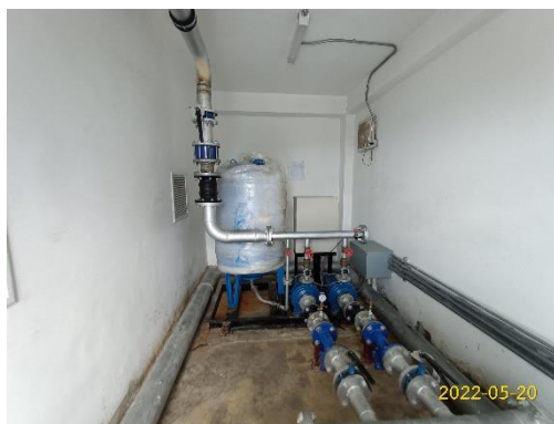
ปั้มน้ำ/ปั้มเสริมแรงดันอาคาร B
